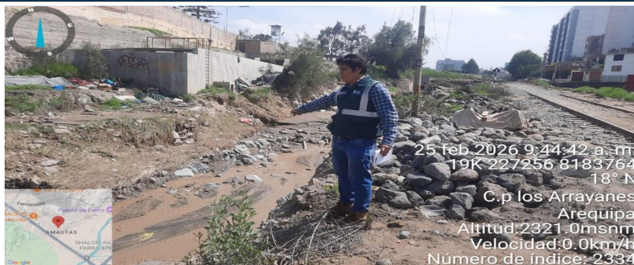
IMAGEN 01: SE OBSERVA LA COLMATACION DE LA QUEBRADA CHULLO PRODUCTO DEL FLUJO DE DETRITOS ACUMULADOS EN EL SECTOR ASI COMO EL
