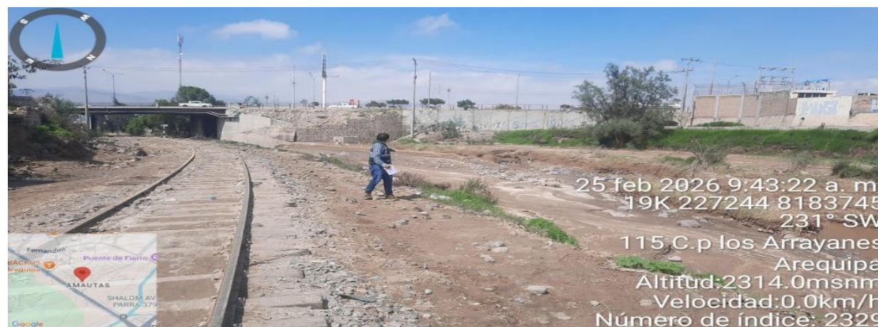
IMAGEN 02: SE OBSERVA QUE REQUIERE DE PROTECCION CON MURO DE CONCRETO ARMADO EN EL TRAMO PARA PROTEGER CULTIVOS, VIVIENDAS Y
